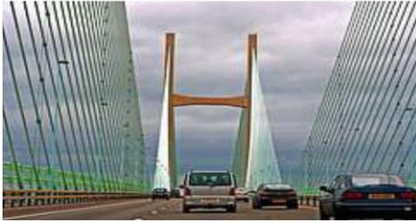
El peso de pilares, la fuerza del viento, y el peso de los carros actúan como cargas para la estructura del puente.
